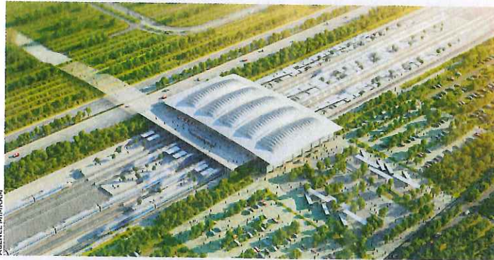
La toiture de la gare-pont sera ondulée dans un sens et plissée dans l'autre pour détourner les vents dominants et favoriser la ventilation naturelle de l'équipement.
